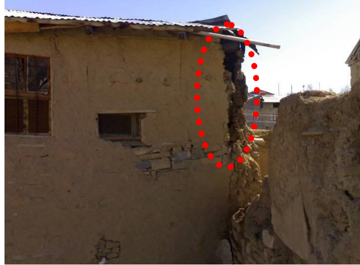
Resim 3.9. Köşe Birleşiminin Kırılması
