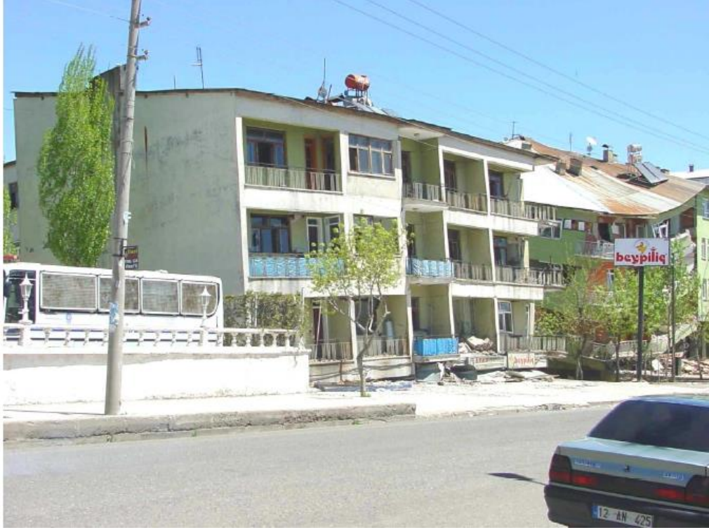
Resim 3.16. Yumuşak Kat Göçmesi (Yıkık)
