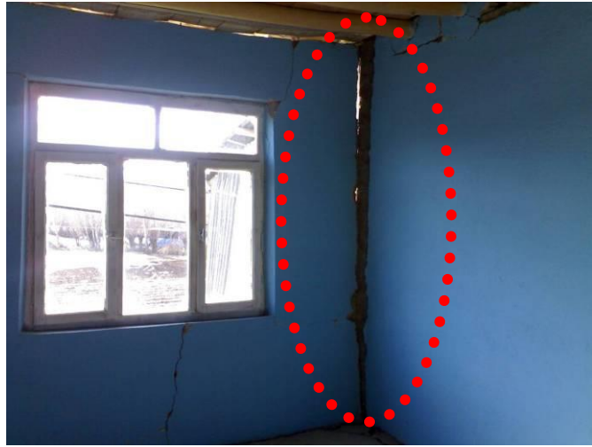
Resim 3.11. Tuğla Duvarlar Arasına Kilit Örgü Yapılmadığı İçin Üst Kat Duvarı Şakülden Uzaklaşmış
